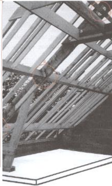
Vue 19 : Fixation des pannes sur l'arbalétrier par sabots
